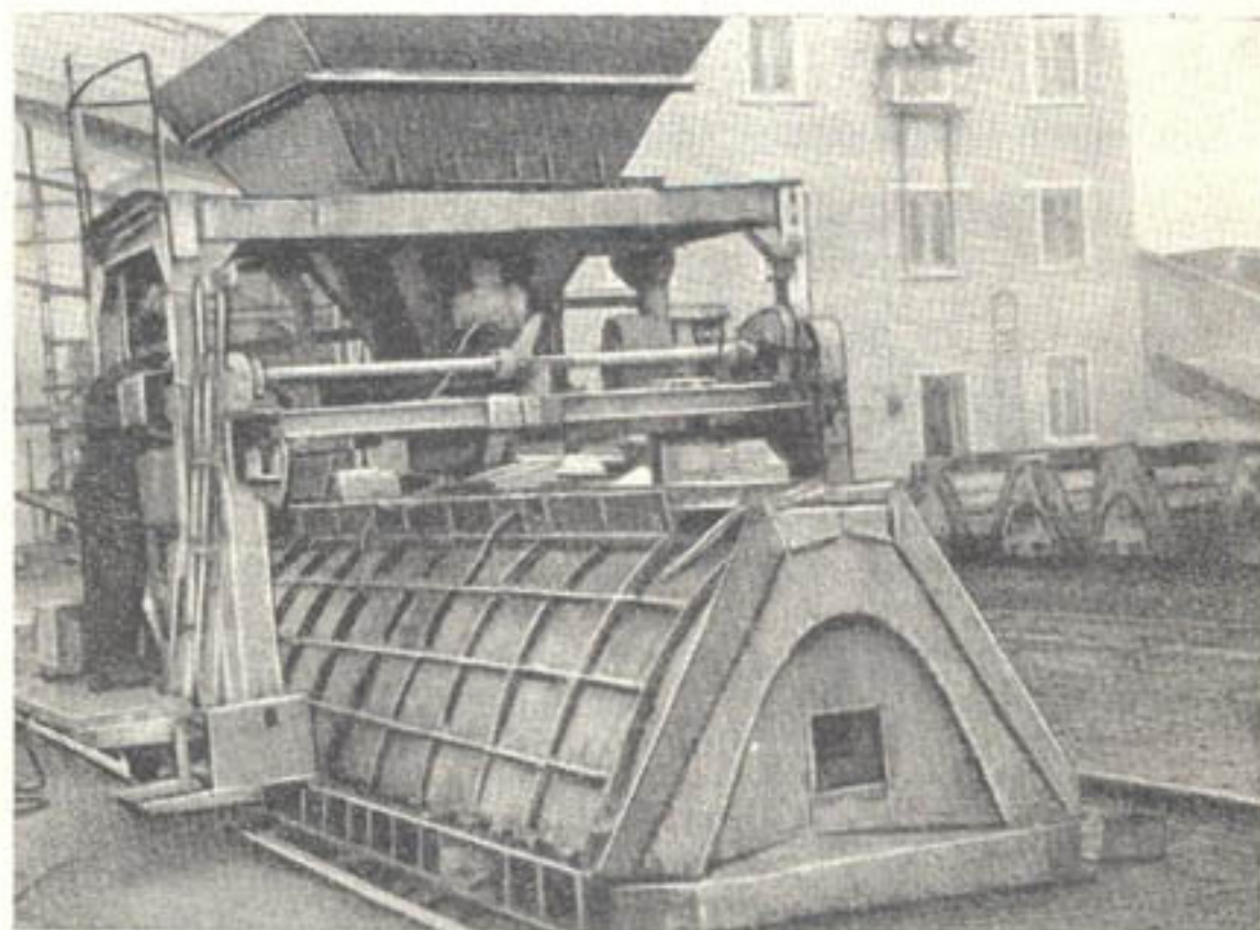
Рис. 116. Формовка лотков глубиной 1 м на виброплощадке.
