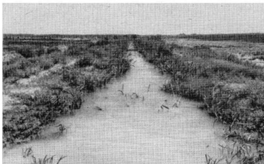
Рис. 21. Канал, экранированный пленкой под слоем грунта, через 6 лет после сдачи в эксплуатацию.
