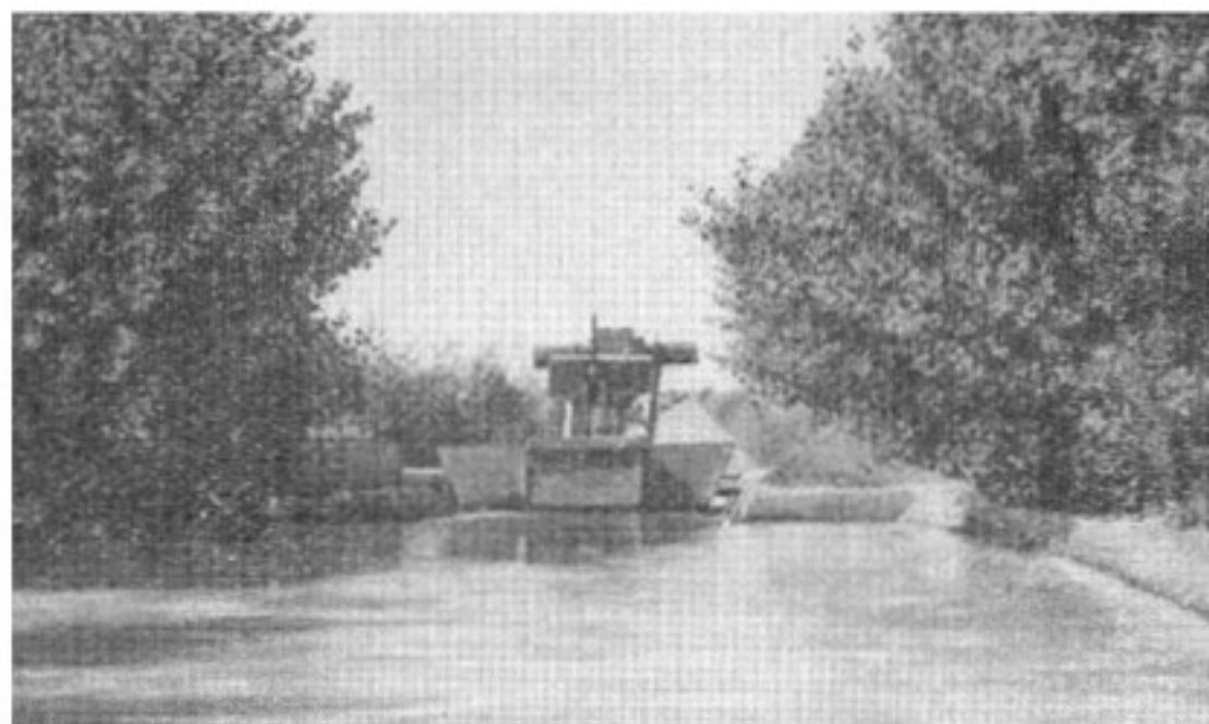
Рис. 34. Автомат постоянного горизонта воды в верхнем бьефе одного из каналов.
