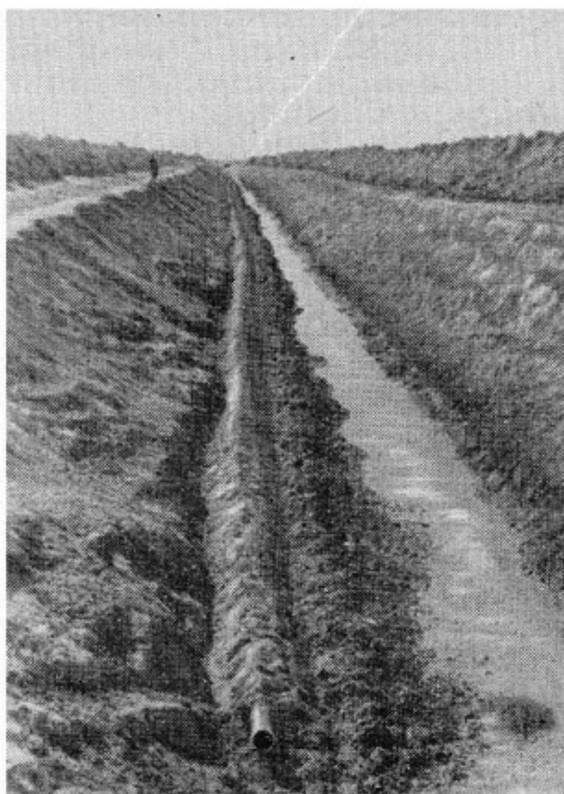
Рис. 49. Дрена, уложенная методом «полки», перед засыпкой.
