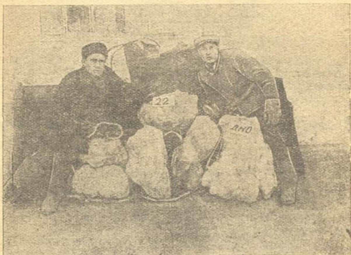
Рис. 3. Накопления прикрепленной шуги на контрольных веревках.
