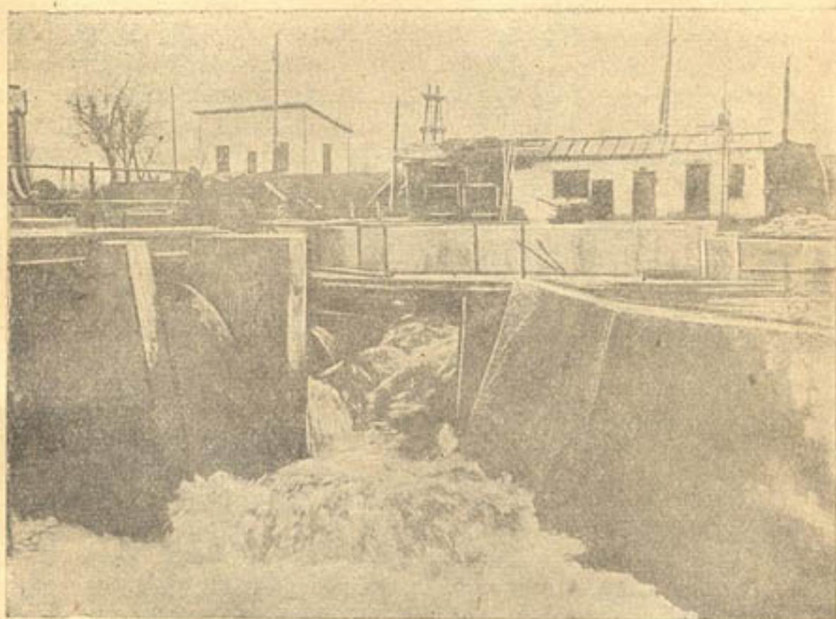
Рис. 7. Выход из лотка в перепад
