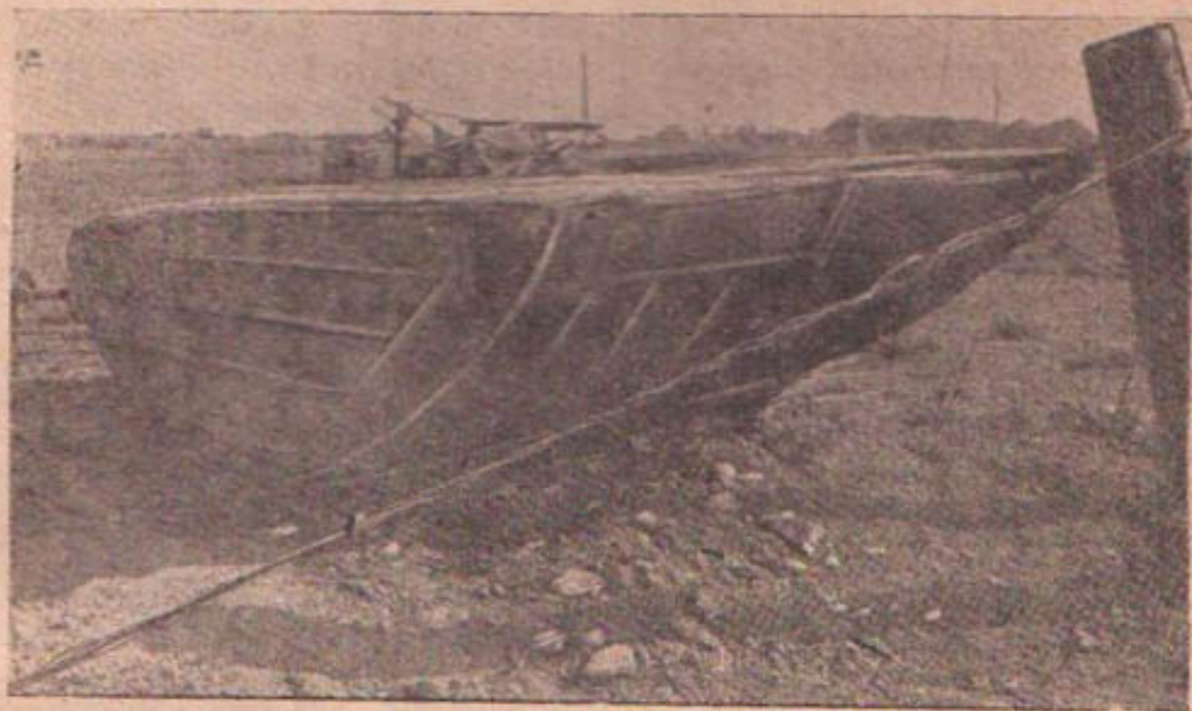
Рис. 4. Вид извлеченного понтона 4. VI — 1938 года. Незначительные механические повреждения видны в хвостовой части. Виднеющаяся в центре дна пробоина — иного происхождения.
