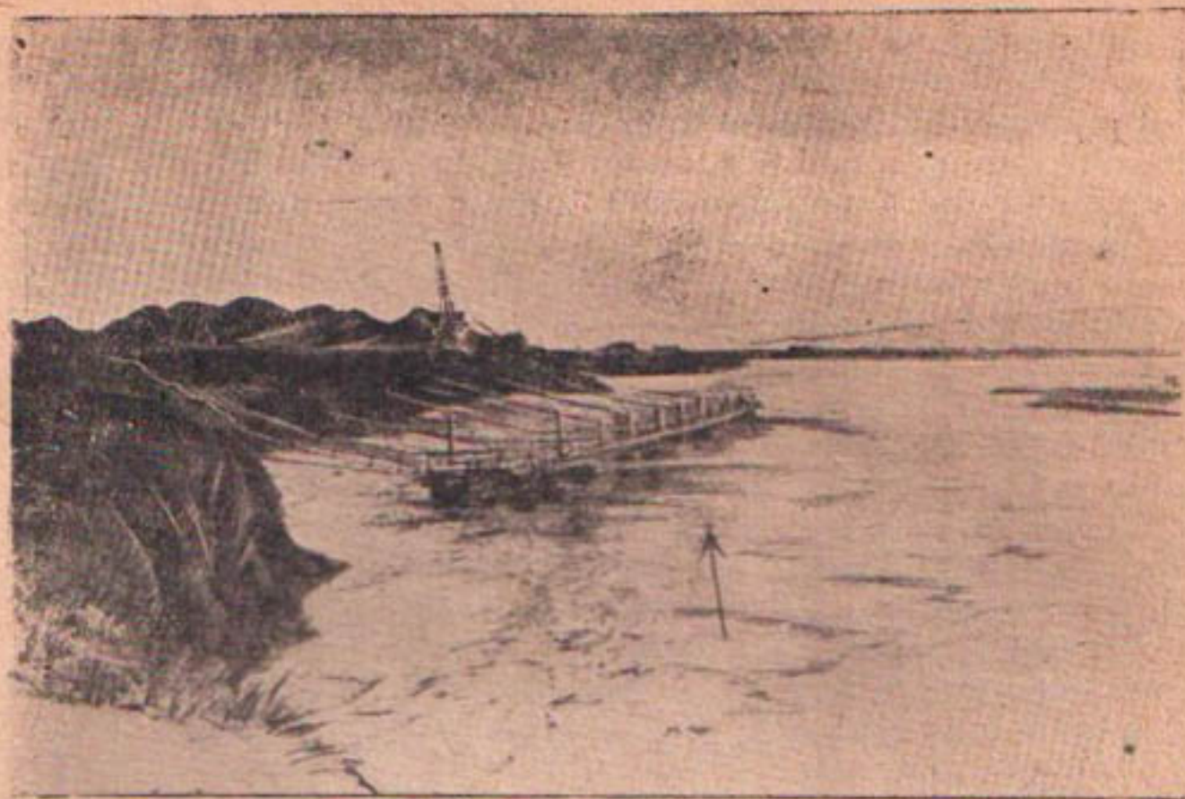
Рис. 2. Общий вид струенаправляющей установки из щитов проф. Потапова на р. Вахш перед головой Вахшского магистрального канала. Вид вниз по течению
