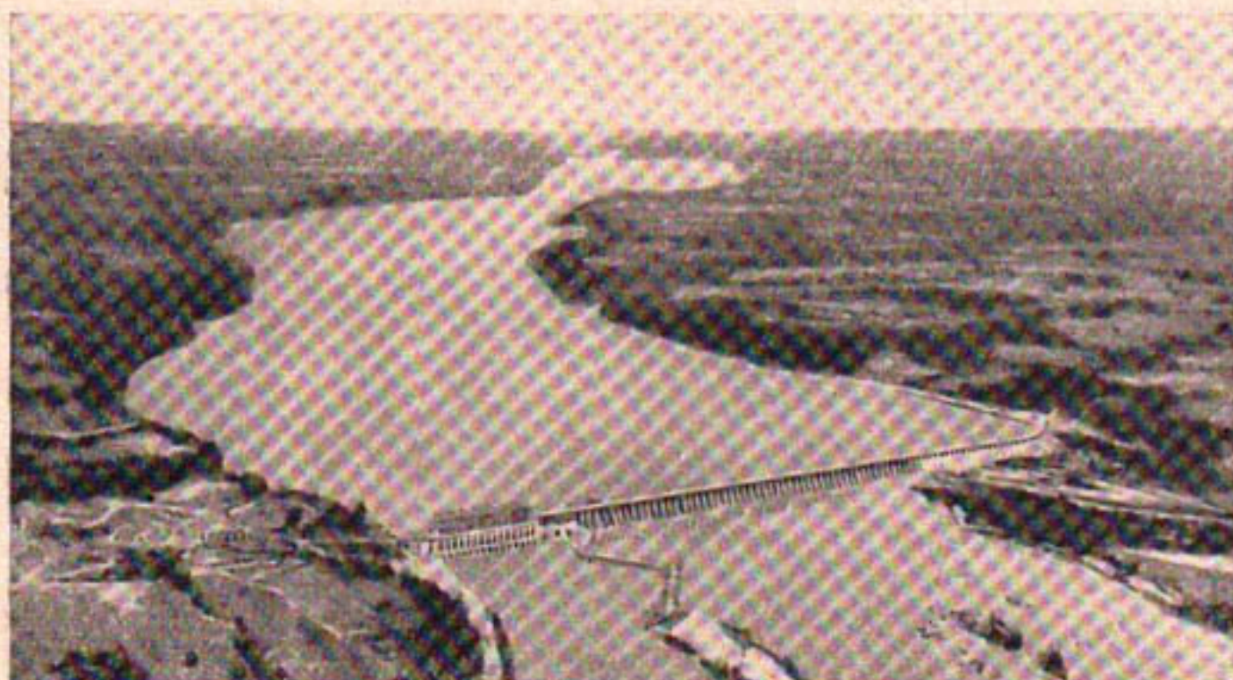
Рис. 4. ГЭС Коновинго, р. Сускегана; ГЭС с суточным регулированием. N = 252 тыс. кВт; H = 27,13 м.
