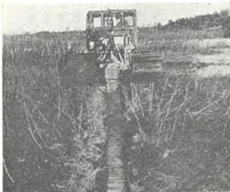
**Мелиоративное строительство:** отрывка траншеи предварительного осушения траншекопателем ТКН-120; строительство канала экскаватором с драглайном; прокладка канала двухфрезерным экскаватором-каналокопателем ЭТР-172А; углубление русла канала земснарядом ЗРС-1.
