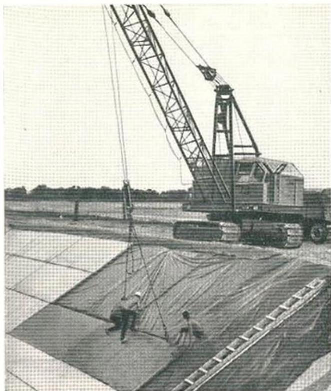
Рис. 73. Устройство комбинированной бетонопленочной облицовки на распределительном канале Р-2 Кяхозской оросительной системы.
