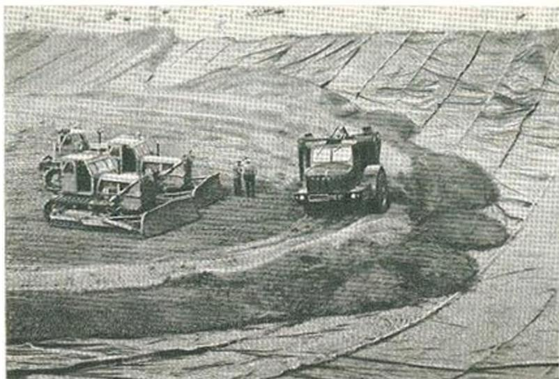
Рис. 26. Покрывание пленочного противофильтрационного укрытия Главного Каховского магистрального канала защитным слоем суглинистого грунта.
