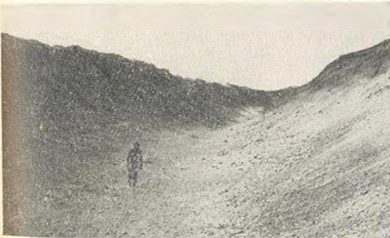
Рис. 27 Участок Каракумского канала, полученный взрывным способом.
